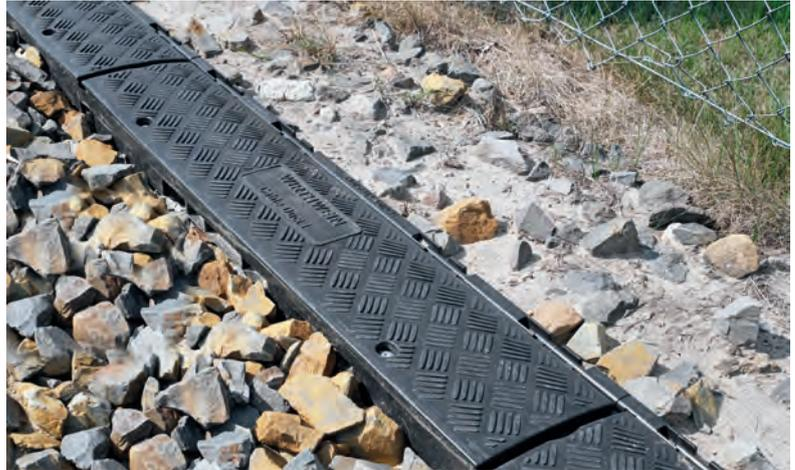
Bei modernen Zugstrecken werden die Kunststoffkanäle für Energie- und Datenleitungen direkt neben dem Gleisbett verlegt. © Wirthwein
