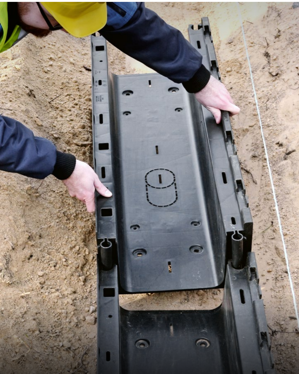
Abb. 1: Kabelkanäle verbinden
